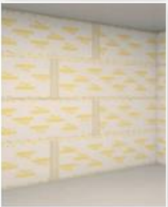
4. Αρμολόγηση κάθετων αρμών
