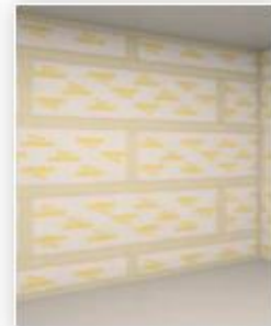
8. Αρμολόγηση οριζόντιων αρμών 2ης στρώσης
