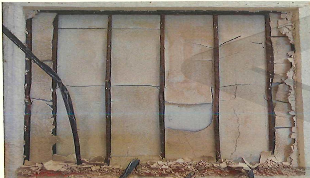
Foto 4: Lato esposto al termine della prova
