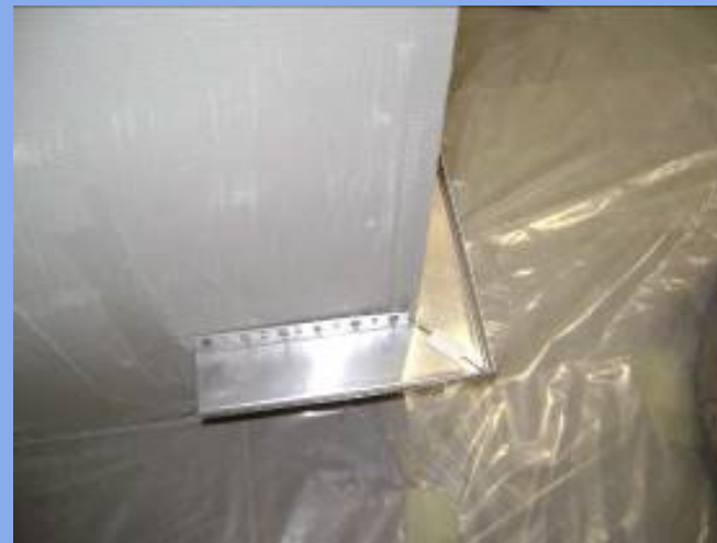
Κόψιμο οδηγού εκκίνησης για τη δημιουργία γωνίας
