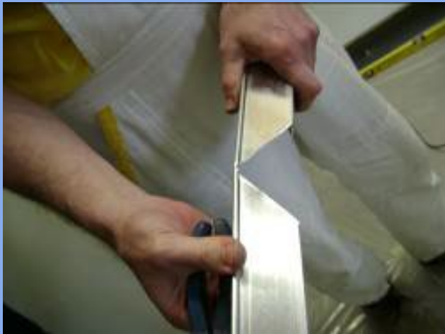
Κόψιμο οδηγού εκκίνησης για τη δημιουργία γωνίας
