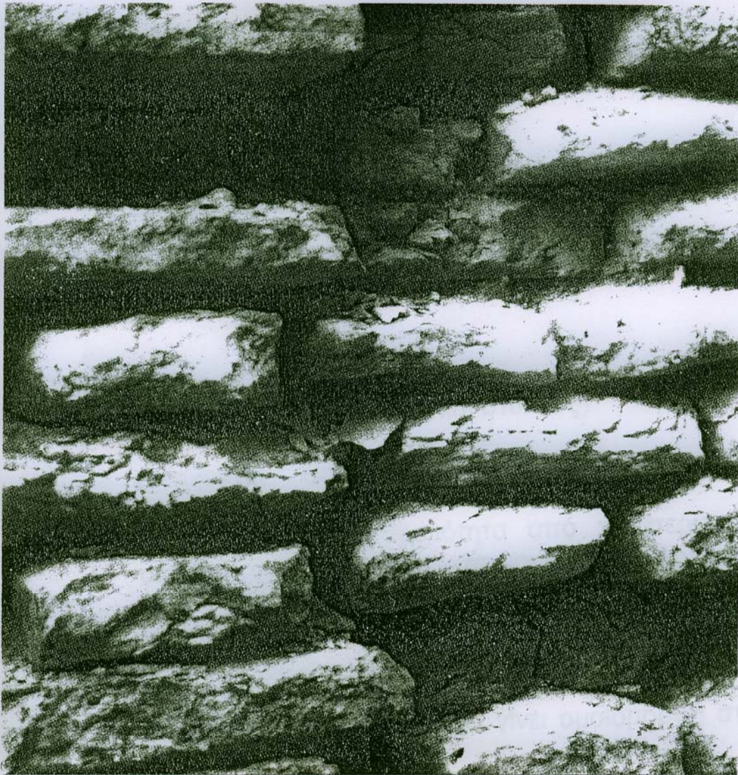
Ρηγματώσεις και απολεπίσεις λιθοσωμάτων, αποσύνθεση κονιάματος σε μεγάλο βάθος (για t/T \approx 90 \lambda. / 900^\circ\text{C} , s \approx 50 \text{ mm} )
